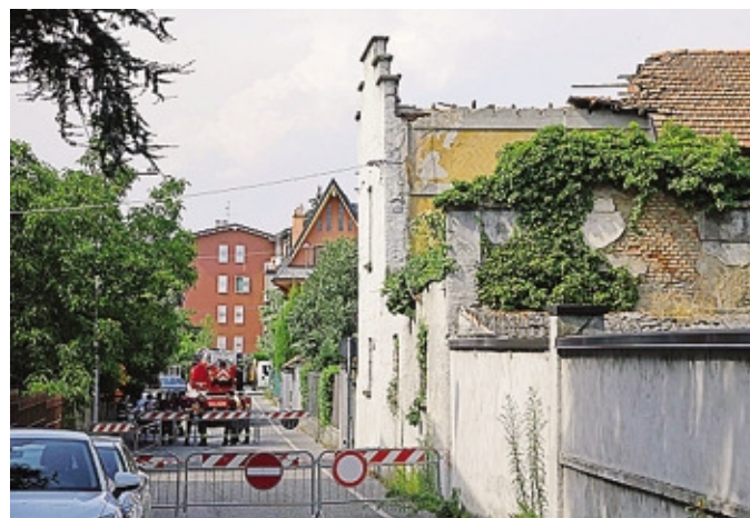
Transenne attorno all'edificio instabile in via Cassani FOTO CESNI
